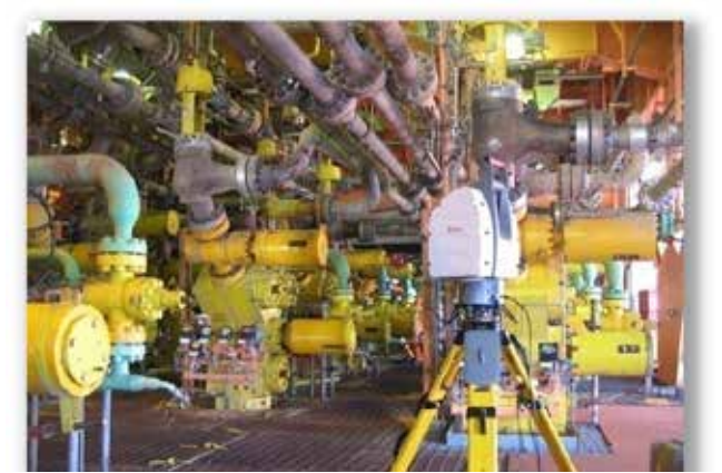
图 8 通过浏览器可以查看整个工厂的建设情况，而无须亲赴现场
